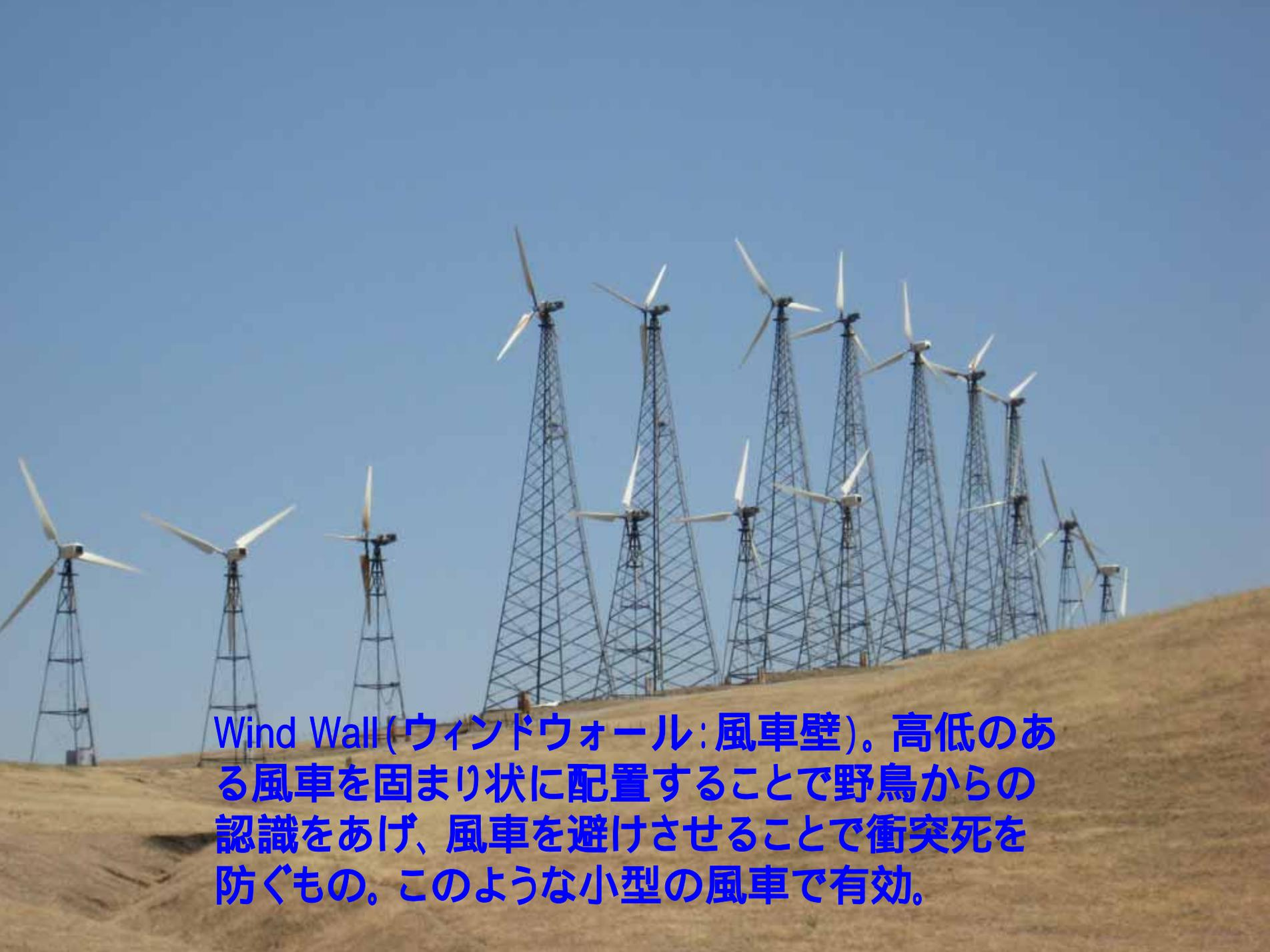
Wind Wall(ウィンドウォール:風車壁)。高低のある風車を固まり状に配置することで野鳥からの認識をあげ、風車を避けさせることで衝突死を防ぐもの。このような小型の風車で有効。
