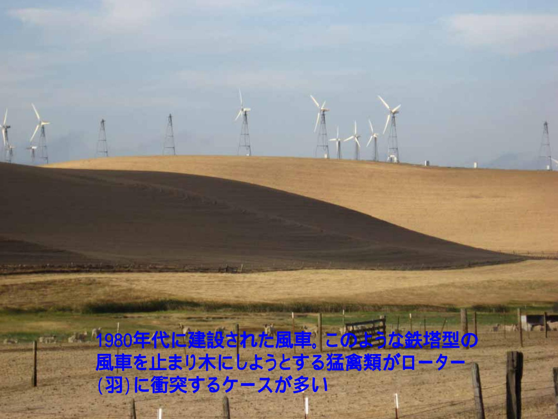
1980年代に建設された風車。このような鉄塔型の風車を止まり木にしようとする猛禽類がローター(羽)に衝突するケースが多い
