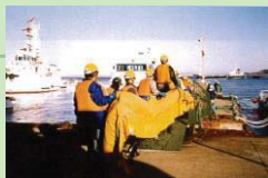
オイルフェンスの張替作業
