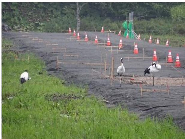
タンチョウの住む湿原を貫く道路工事
